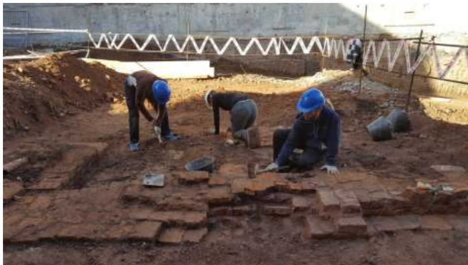
Fig. 11. Vista de los cimientos de dos de las construcciones que existieron en el sitio. En primer plano, los restos de un ancho de basamento de ladrillos partidos; a la izquierda, en ángulo recto, dos hiladas en los restos de un muro más moderno y angosto construido con ladrillos enteros.
