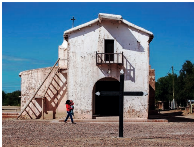
Figura 10. Iglesia de Nuestra Señora del Rosario en Guanacache, Mendoza, Argentina, con su balcón y acceso por escalera externa. Una capilla que apeló al mismo sistema de misa al exterior en atrio abierto. Fotografía: Archivo del Centro de Arqueología Urbana.
