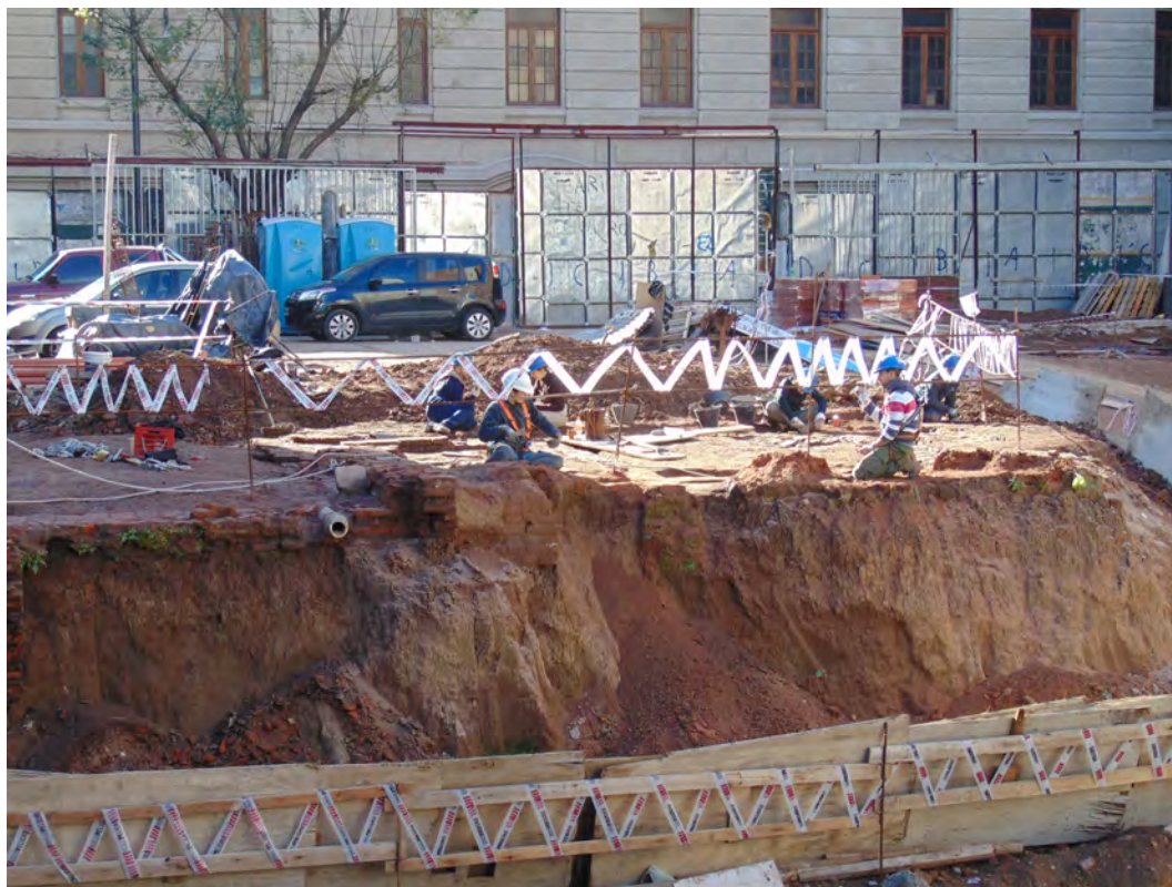
Figura 9. miembros del equipo arqueológico trabajando próximos a un área con peligro de desmoronamiento con todos los elementos de seguridad correspondientes (Foto: A. Igareta).
