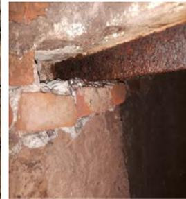
Cúpula sobre el pozo circular antiguo y los arreglos posteriores; viga de hierro de la unión entre ambos.
