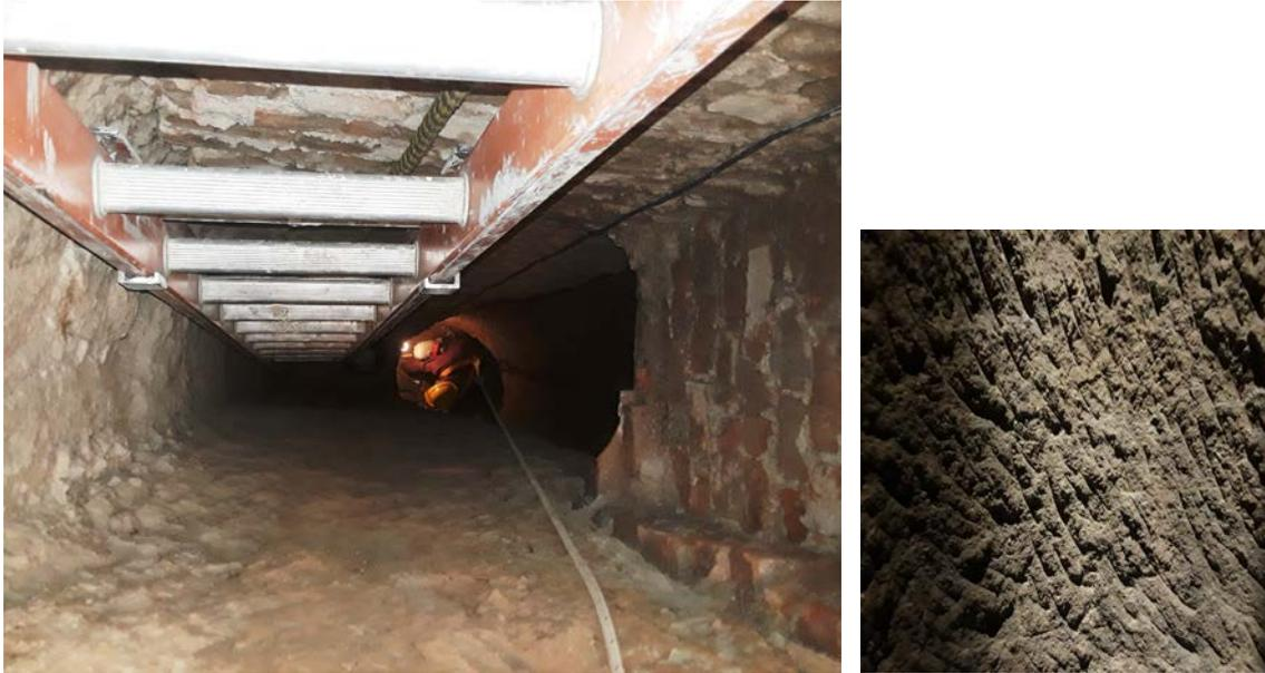
Vista de los dos pozos unidos por debajo de la cúpula y la diferente forma de excavarlos que se ve en ambas paredes.
