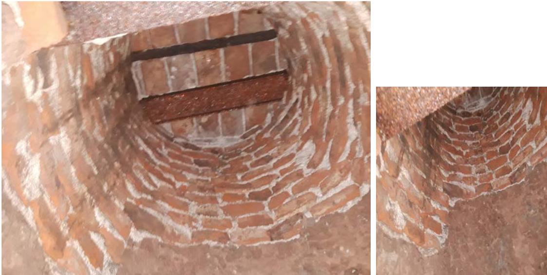
Vistas del interior de la bovedilla del pozo circular: se observa la irregularidad con que se apoyaba en la tierra y los hierros irregulares usados para sostenerla.
