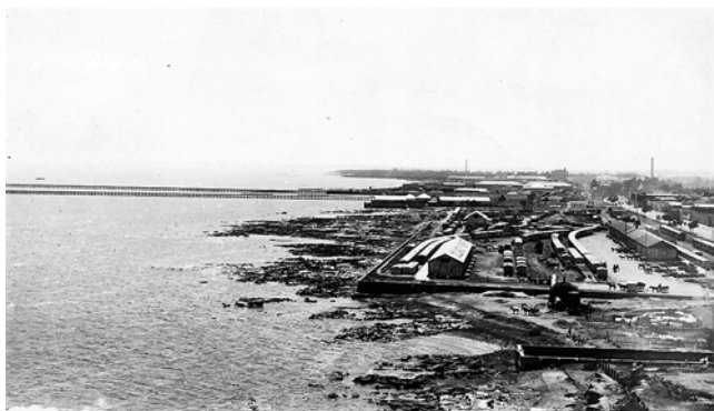
Figura 5 Muelle de las Catalinas que se internaba en el río trescientos metros entre 1872 y 1894; se observa la irregularidad del fondo expuesto en las orillas (Fototeca del Instituto de Arte Americano).
