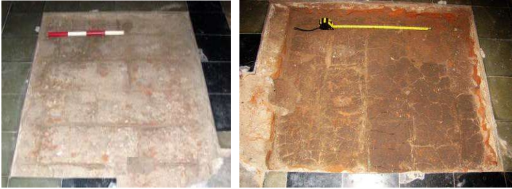
Sondeo 2: piso de ladrillos original y contrapiso de tierra mostrando las marcas de cada mampuesto, indicando que fueron puestos sobre barro líquido.
