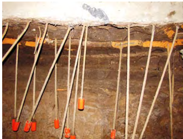
9. Nivel del piso y contrapiso original con los restos de las baldosas cuadradas visibles en el perfil expuesto en la obra.
