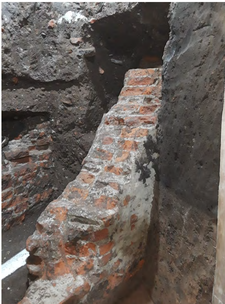
11. Estructura C, parte del basamento A que continúa en una zanja para cañerías aledaña. El caño blanco fue colocado en medio del muro, pero la altura conservada es mayor que en el resto del sitio.
