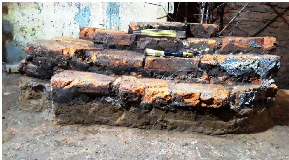
10. Restos de un muro o pilar de cuatro hiladas de ladrillos (Estructura B), con juntas de barro, colocado sobre la tosca original.
