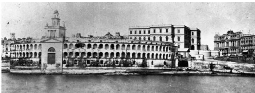
17. El edificio ya clausurado, el muelle demolido, listo para ser destruido. Nótese el túnel de entrada al Patio de Maniobras a la derecha y la rampa al nivel superior (Archivo General de la Nación).
