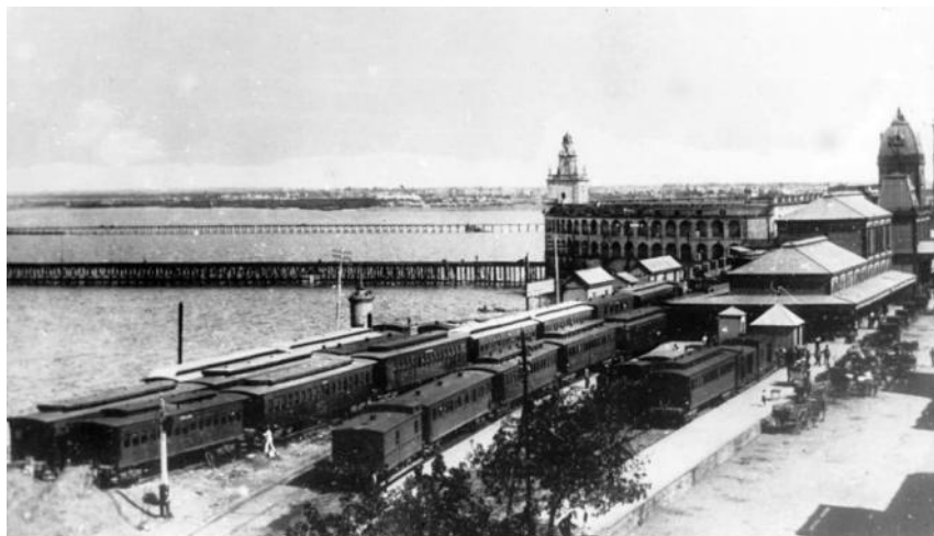
Complejo norte de la Aduana: el edificio central, el muelle de mercaderías y la estación del FFCC Central. Un conjunto organizado para la importación y exportación a gran escala.
