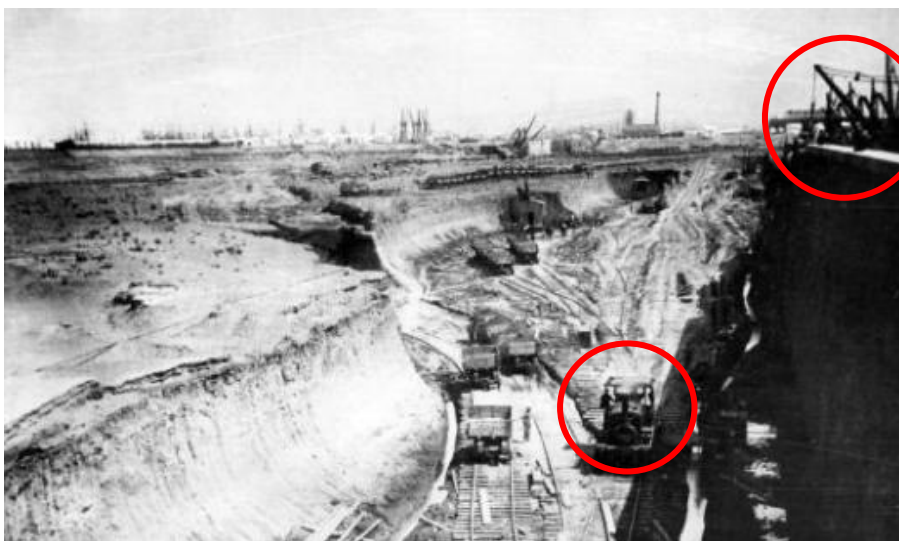
20. Vista de los rellenos entre el puerto y la Aduana, se ve una locomotora a la derecha y vagones para mover tierra a la izquierda; arriba a la derecha el nivel de piso actual con las grúas: dimensiona las obras que se hicieron (Archivo General de la Nación).
