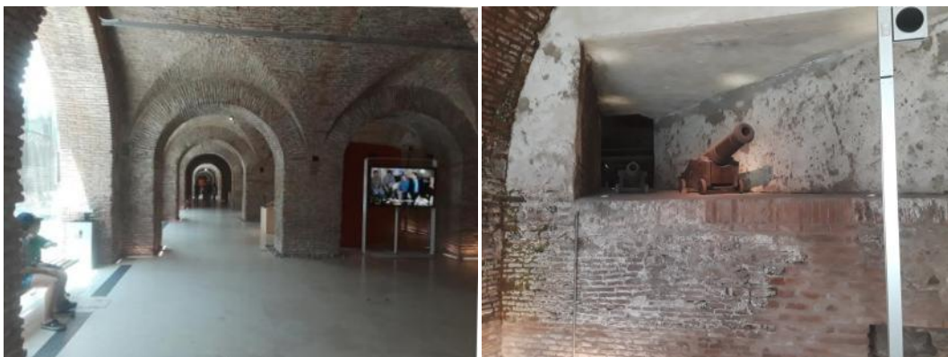
Sectores del antiguo Fuerte remodelados por las obras de la Aduana y los trabajos posteriores a 1938 unificando el conjunto.
