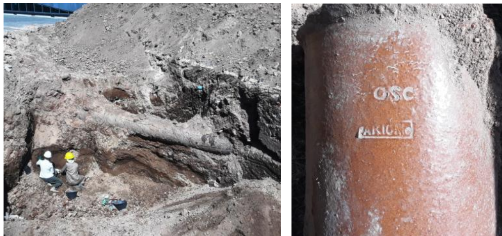
Intrusiones: caño de hierro de 50 cm de diámetro para agua potable, fuera de uso, colocado durante el relleno del lugar y caños de cerámica vitrificada de desagüe a tres metros y medio de profundidad hacia el río.
