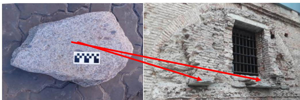
Laja arenisca tallada, en este caso similar a las que sostienen las ventanas de los arcos tapiados de la galería del Museo.
