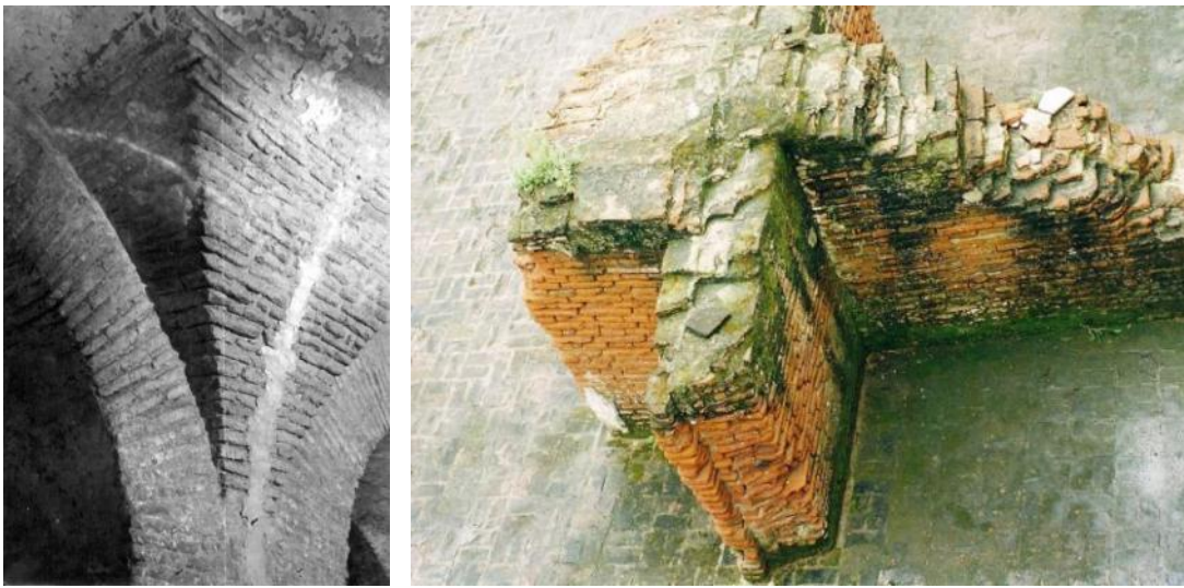
Pilares: de la galería y del Patio de Maniobras: fotos de 1960 (archivo M. J. Buschiazzo) y de 1992.
