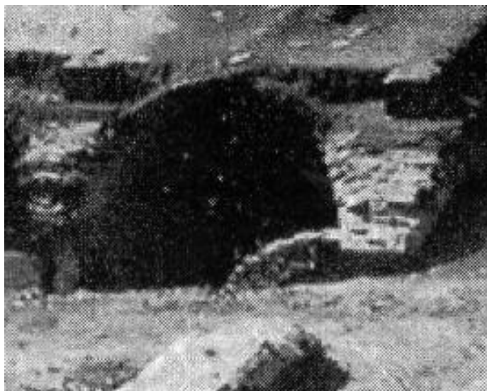
24. Detalle ampliado de una de las fotos de la demolición en que se observan bóvedas menores bajo las de mayor tamaño.
