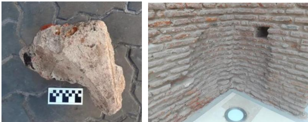
Evidencias de estructuras rotativas (grúas y guinches): bloque curvo de mampostería de cal, y desgastes en los pilares dentro del Museo que han perdido su revoque.
