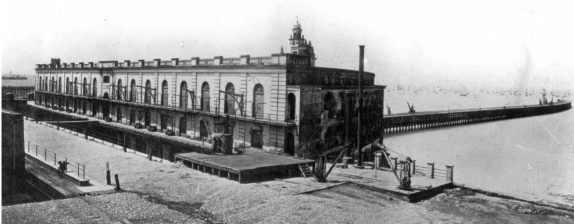
Fachada de la Aduana hacia el Oeste, a sus pies el Patio de Maniobras, se ven los pescantes de las grúas para cargar las mercaderías. El estilo arquitectónico es inconfundible (Archivo General de la Nación).
