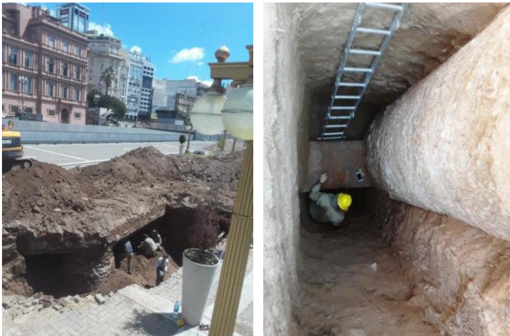
Estructura de hormigón construida al terminarse la demolición: losa y columnas.
