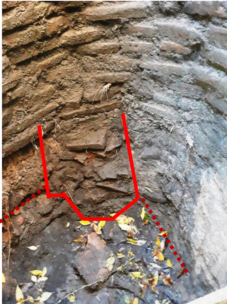
Canal de entrada del agua al aljibe y nivel de piso (punteado). Foto pos-excavación (Foto M. Martínez).
