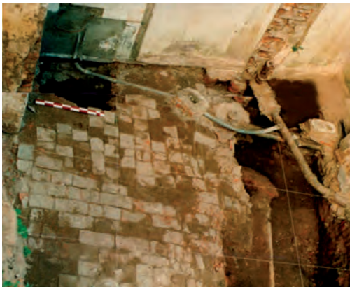
Piso de la Imprenta en su etapa pre 1895 de ladrillos irregulares y parches, abajo asoma la boca del aljibe. Las cañerías son del siglo XX y la sección destruida fue por el derrumbe del edificio.
