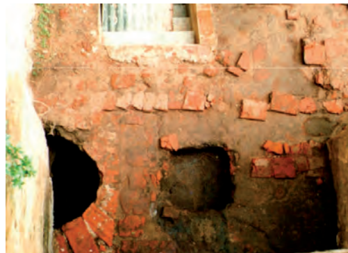
Excavación del Local 16, a la izquierda el pozo compartido con el vecino fechado en el siglo XVIII, arriba la escalera del siglo XX que comunicó con el edificio lindero.
