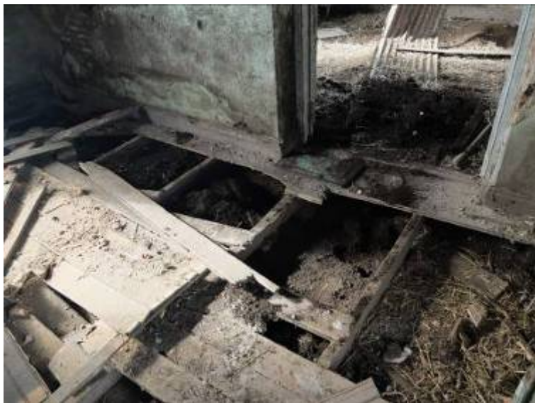
Figs. 54 y 55. Tierra limpia de contrapiso (Habitación 2), tirantes enganchados en los cimientos y entablado del piso, se alcanza a ver los marcos de la puerta y los zócalos pintados de verde sobre el celeste original, igual que la pared. Detalle de remiendos hechos con chapas.
