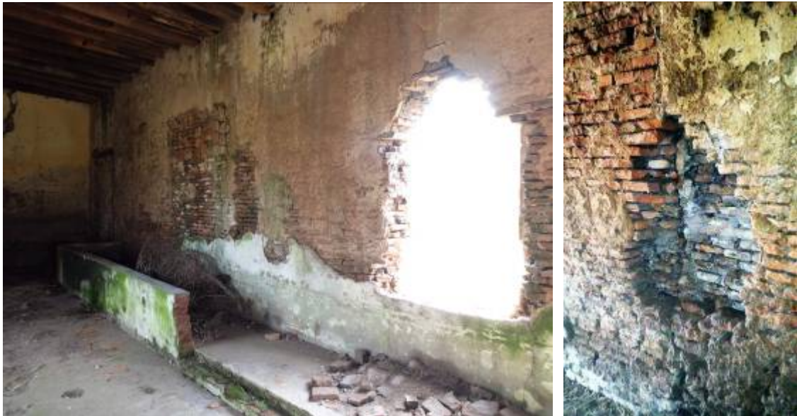
Figs. 56 y 57. Ambiente 16, resultado de demoler varias paredes y cambiar sus aberturas; nótese la peculiar pared del Sur hecha como dos muros unidos entre sí, ambos con ladrillos con junta de barro.
