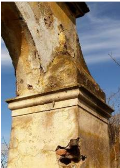
Figs. 15 y 16. Pilar de la primera época del pórtico, luego cortado para colocar la cartela decorada. Compárese con un pilar de la Casa Casco en Chascomús.
