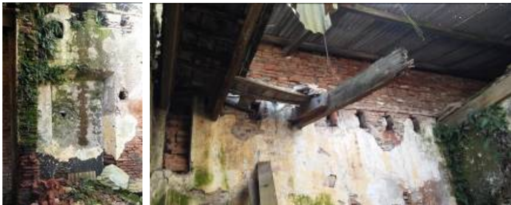
Figs. 21 y 22. Puerta abocinada en la casa más antigua y evidencia del techo original y sus modificaciones.
