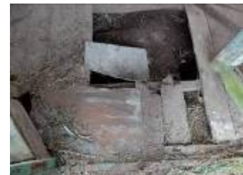
Figs. 54 y 55. Tierra limpia de contrapiso (Habitación 2), tirantes enganchados en los cimientos y entablado del piso, se alcanza a ver los marcos de la puerta y los zócalos pintados de verde sobre el celeste original, igual que la pared. Detalle de remiendos hechos con chapas.
