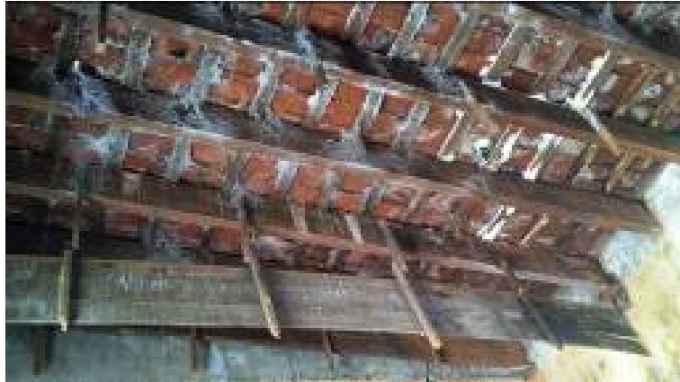
Figs. 47. Detalles de la original solución del cielorraso de la sección antigua hecho con tablones del piso.
