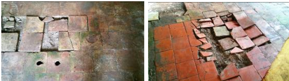
Figs. 36 y 37. Baldosas del Havre con agujeros intencionales, y parche hecho por baldosas de Marsella para cubrir un hundimiento relleno con tierra.
