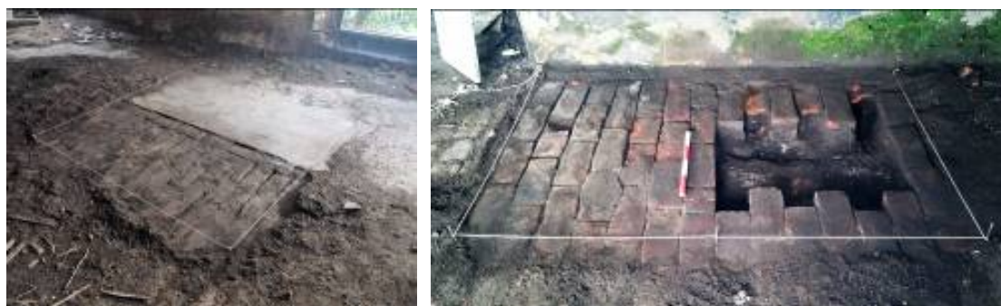
Figs. 32 y 33. Limpieza de parte del piso del salón con los dos tipos de materiales usados a ambos lados del mostrador; excavación de un sector donde los ladrillos fueron puestos sobre una capa de tierra negra sin evidencias de construcciones anteriores.
