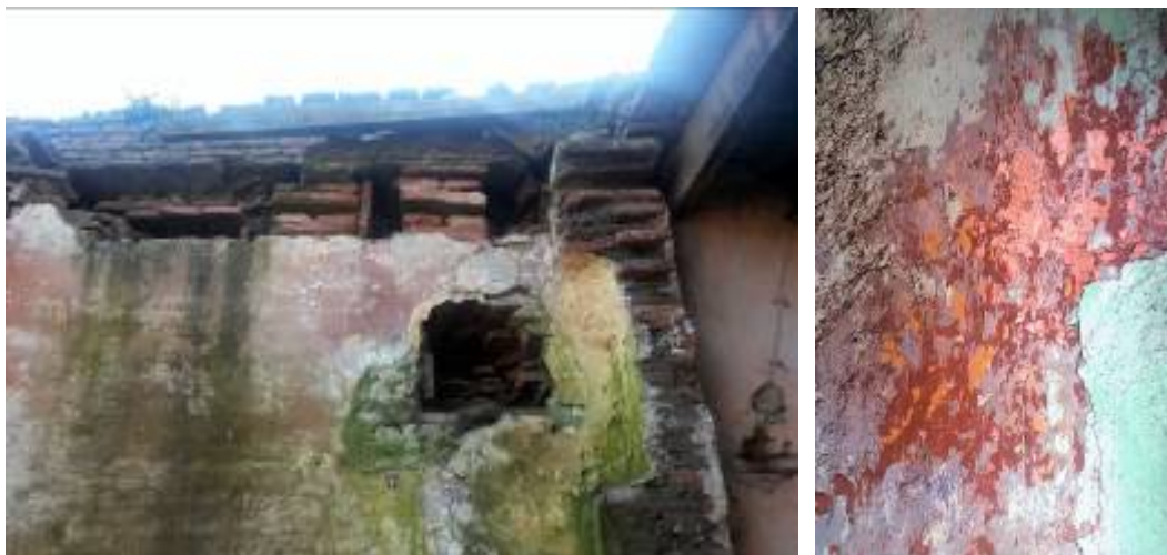
Figs. 45 y 46. Sistema de mechinales para las vigas originales y restos de estratos de pinturas de la casa más antigua, plenamente decorada.
