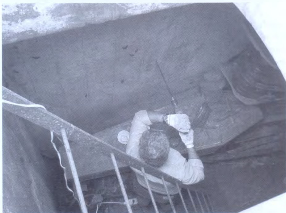
Perforación del muro en el interior de la bóveda
