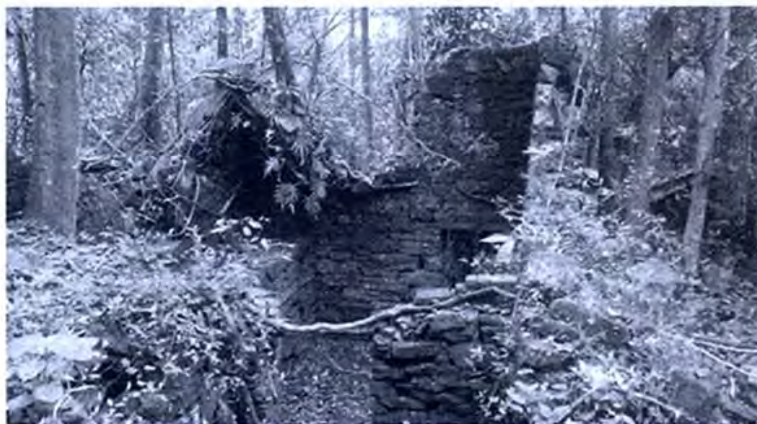
Figura 2: Vista del interior de la Estructura II. Por la puerta de la planta baja a la derecha estaba ubicado el Pozo de basura 4
