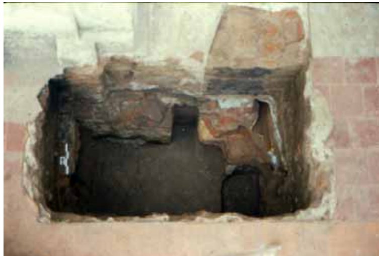
Vista de las basas y el nivel del patio original, aun conservados bajo los pisos actuales.
