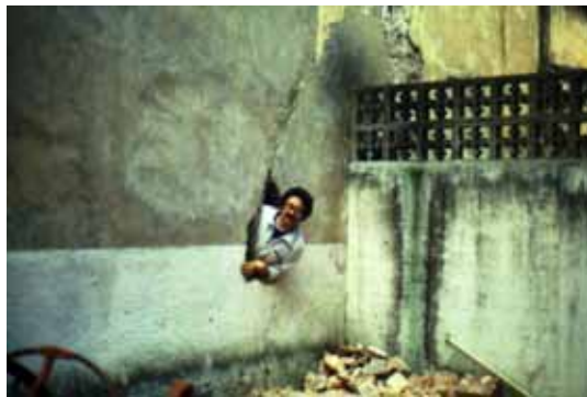
Muro sur de la Capilla con el descubrimiento de la puerta tapiada al sur.
