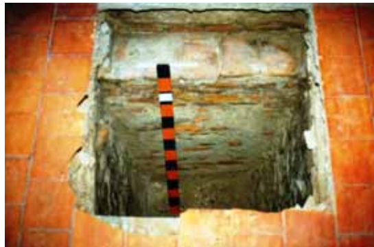
Vista de la parte superior de los cimientos durante la excavación de 1991.
