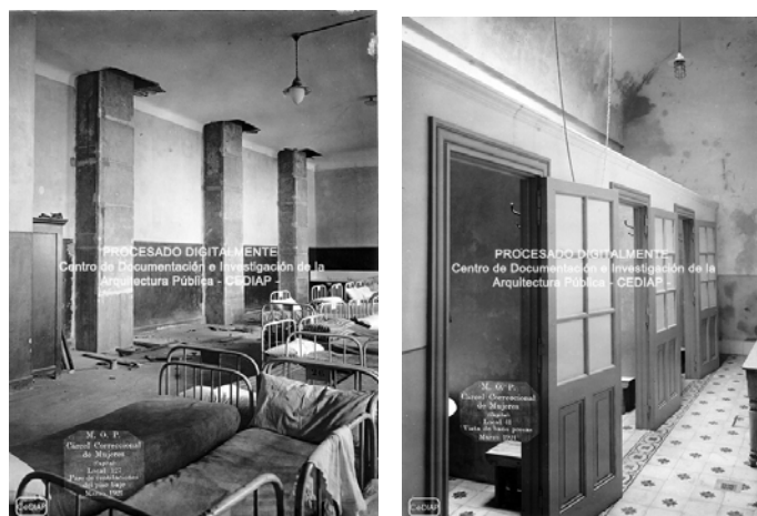
Vistas del interior durante las obras de 1921 (Archivo Cediap)
