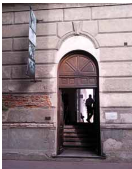
Puerta de Benoit, los escalones, ahora de doble altura, están en el interior, la puerta ha sido bajada.
