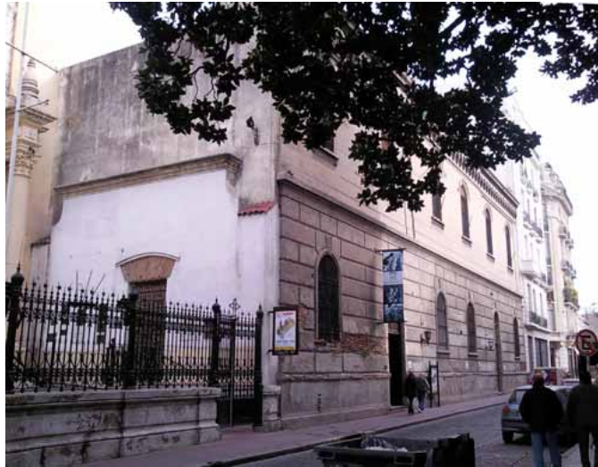
Entrada original a la Casa de Ejercicios desde el atrio, rehecha en estilo neocolonial al lado de la fachada de 1883.
