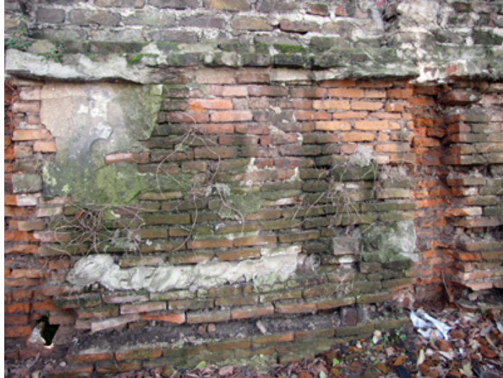
Detalle del muro Reid desde el lado sur.
