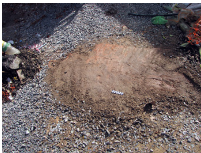
Vista del piso original al removerse el pedregullo, pero que los ladrillos se disgregan por culpa de esa acción de supuesta protección tomada en 1998.
