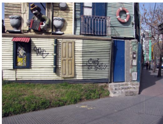
Escalera que indica que el nivel de la calle fue modificado en relación al interior al hacerse el mural (obra moderna que ya ha sido trasladada) y no puede tomarse en consideración para medir posibles alteraciones.
