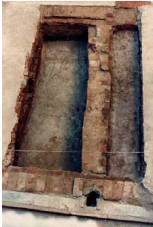
Excavación en el centro del Patio I con los cimientos de los muros de 1865.
