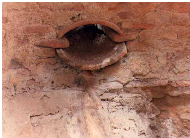
Cisterna de aljibe con su albañal que baja sobre la pared, apoyado sobre el túnel. La parte superior fue rota pero no relleno y cubierto con maderas. Nótese las tejas usadas para la entrada de agua.
