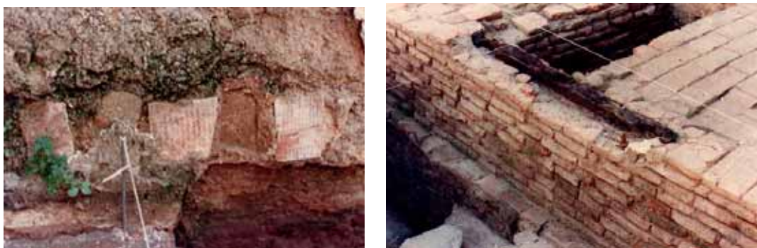
Detalles constructivos del sector: baldosas franceses de piso puestas en la pared como relleno, umbral de una puerta original que quedó olvidado al desarmar el muro y ponerle la cubierta de asfalto.
