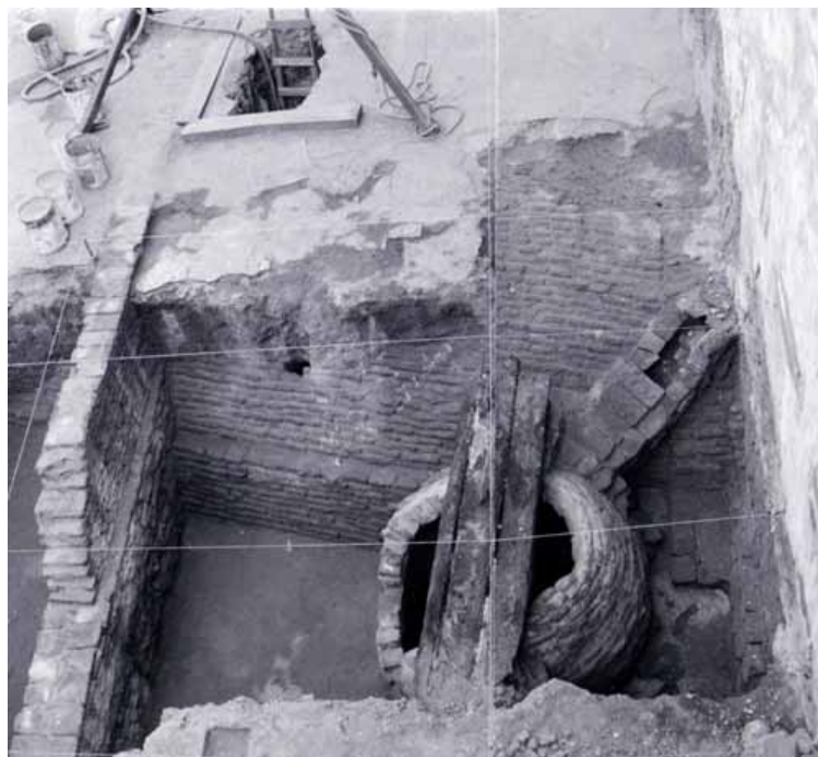
Sección de la parte exterior de la bóveda que cubre el túnel tras ser excavado, a un lado una cisterna de aljibe (rota y apuntalada con vigas), con el antiguo albañal que va a la pared.
